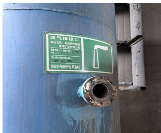
粗碎车间 DA002 排气筒、采样口、排污标识
