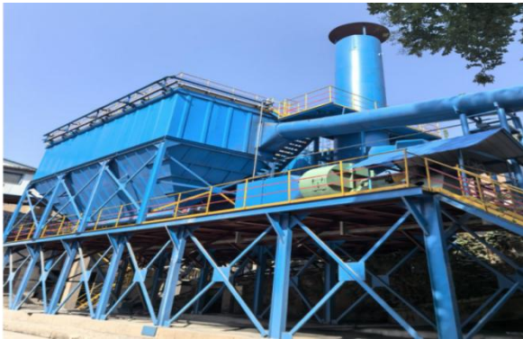
中细碎车间除尘器、排气筒 DA004、采样平台
