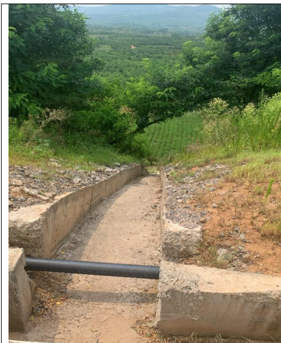
尾矿库B区边坡排水沟
